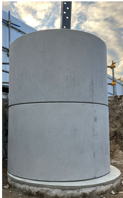
図 5 : プレキャスト基礎現場施工状況写真
