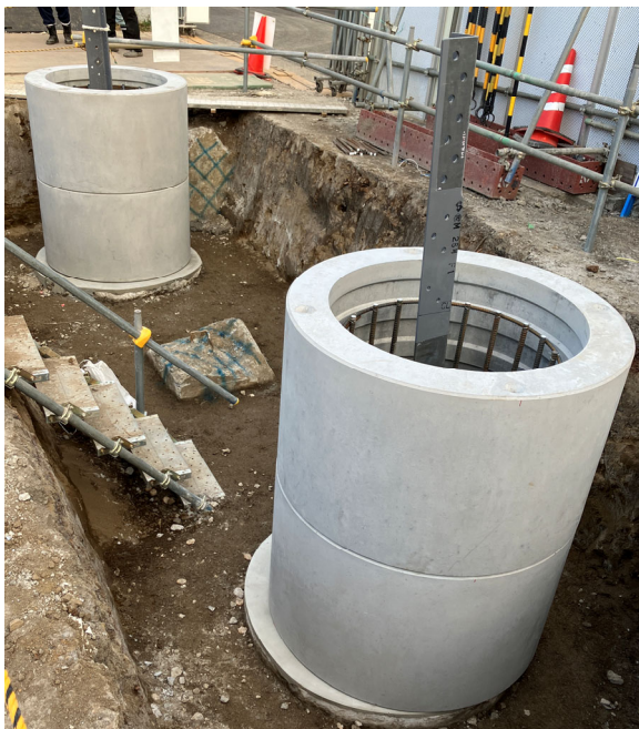
図 5 : プレキャスト基礎現場施工状況写真
