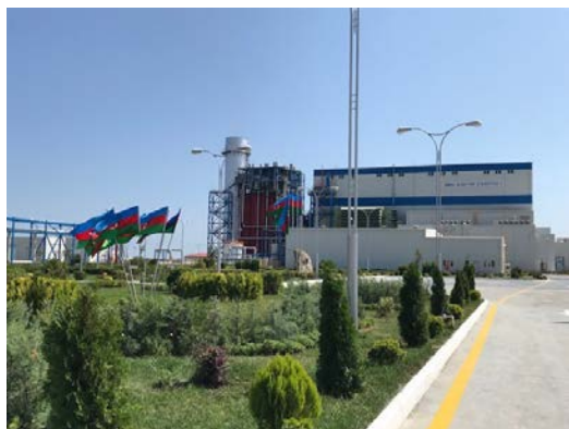
シマル2号機火力発電所 (佐藤所長提供)
